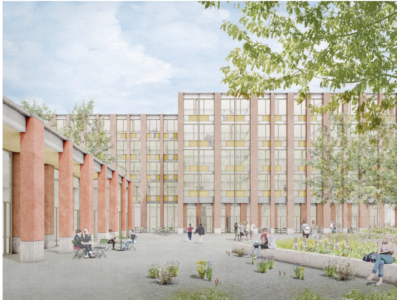
Neubau Kantonsschule Ausserschwyz in Pfäffikon
