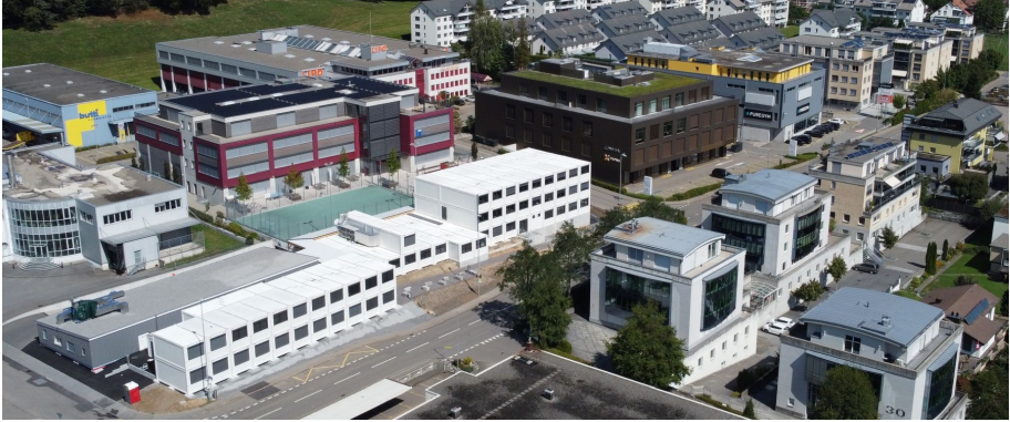
Das KSA-Schulprovisorium an der Eichenstrasse in Pfäffikon.
