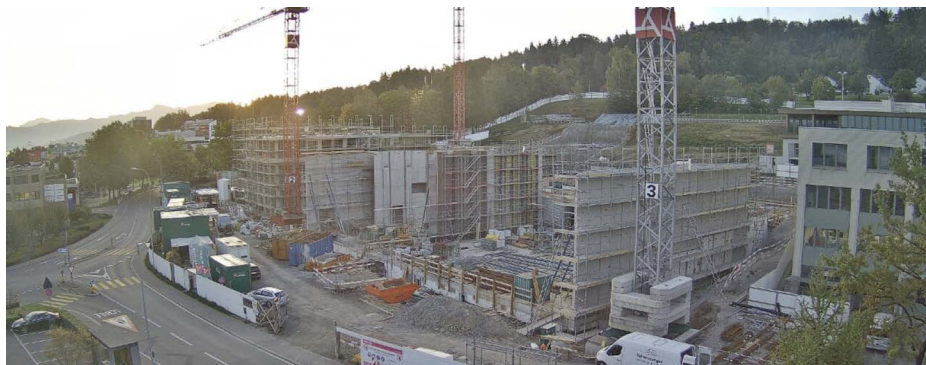
Die Baustelle des KSA-Neubaus. Webcam-Screenshot vom 13.10.2023.
